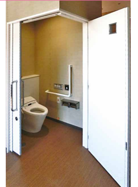
●病室内トイレ/BWLHタイプ
