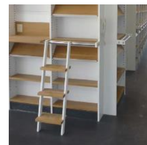
書架前面にパイプを通して設置し、簡易閲覧スペース・梯子掛とした。
