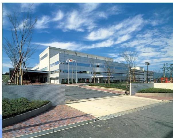
津工場 三重県津市片田町731-2 片田工業団地内
