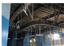
塗装表面処理排水
