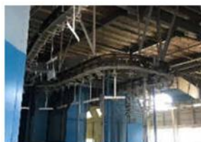
塗装表面処理排水
